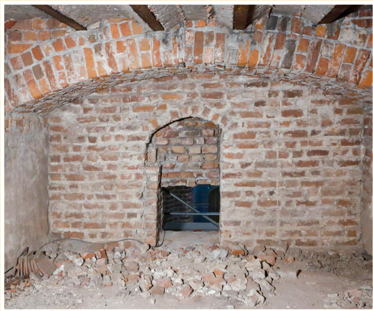
Interiér objeveného prostoru nad malou sakristií
