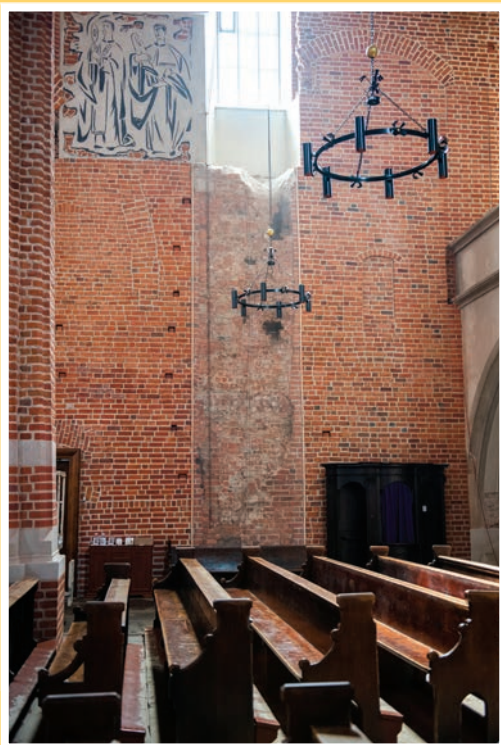
Obrysy objeveného oválného schodiště
