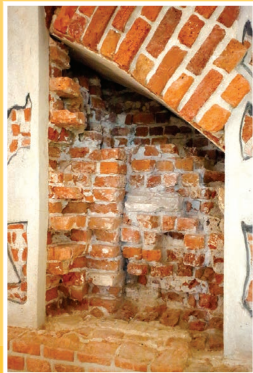
Část zazděné arkády možné kaple nad velkou sakristií
