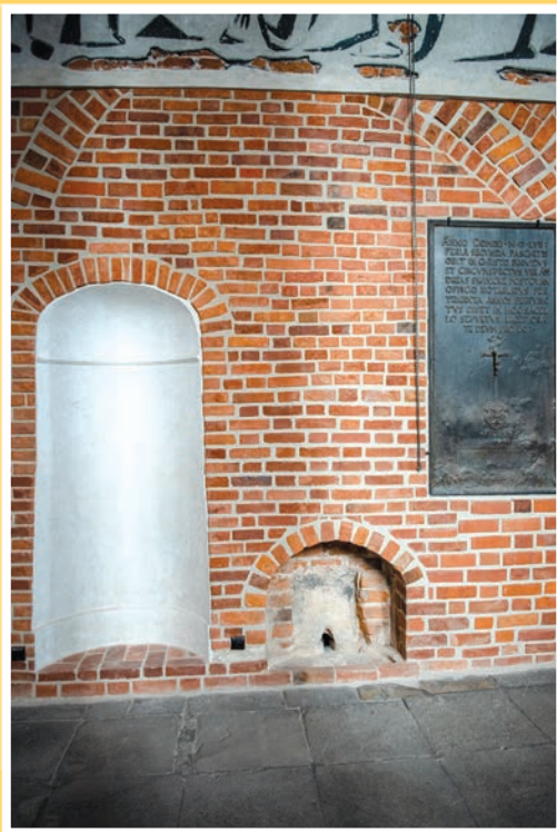
Výklenek ve zdi pro umývání rukou s odvodem vody
