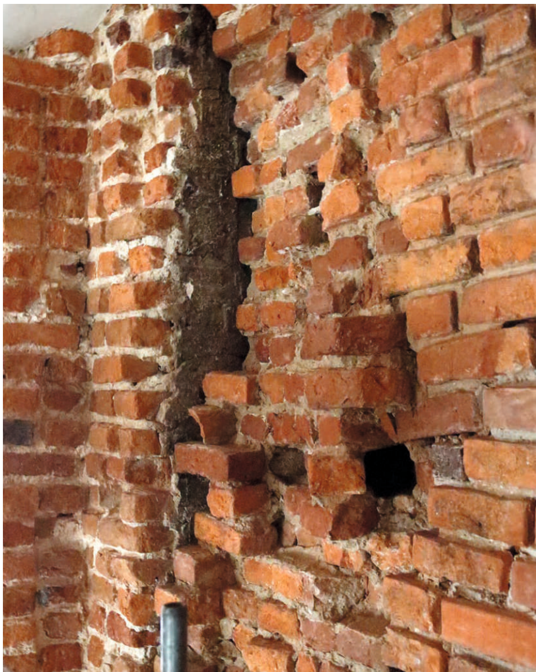
Ilustracja 56. Nawapółnocna w trakcie prac konserwatorskich. Odkryty relikw muru poprzecznego ze skośnie wyprowadzonymi ceglami w górnej partii ściany nawy. Fot. A. Nowak, 2018
