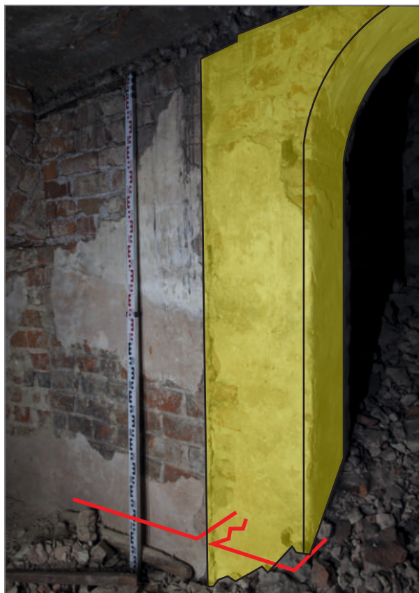
Ilustracja 46. Pomieszczenie nad małą zakrystią, narożnik północno-wschodni, zachowana przypora południowa. Fot. P. Filipowicz, 2019
