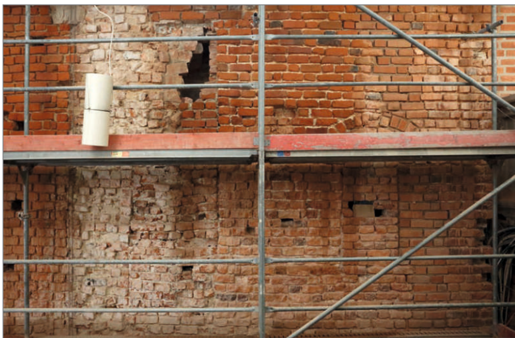
Ilustracja 19. Ściana nawy południowej z widocznymi miejscami odkryć klatek schodowych, nieregularnym przemurowaniem biegu okrągłej klatki po stronie lewej i zamurowanym okienkiem prowadzącym do pomieszczeń nad zakrystiami po stronie prawej. Fot. A. Nowak, 2019
