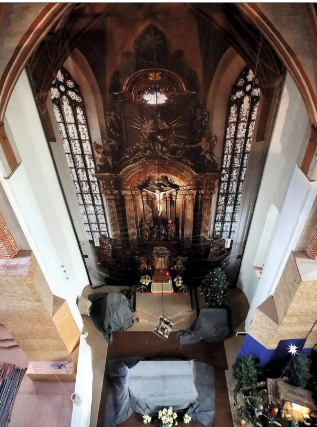
Ilustracja 31. Nawagłówna w trakcie prac konserwatorskich przy sklepieniu. Widok z rusztowania na prezbiterium zasłonięte wielkoformatowym banerem z nadrukiem zdjęcia jego wnętrza z ołtarzem głównym. Fot. A. Nowak, 2020
