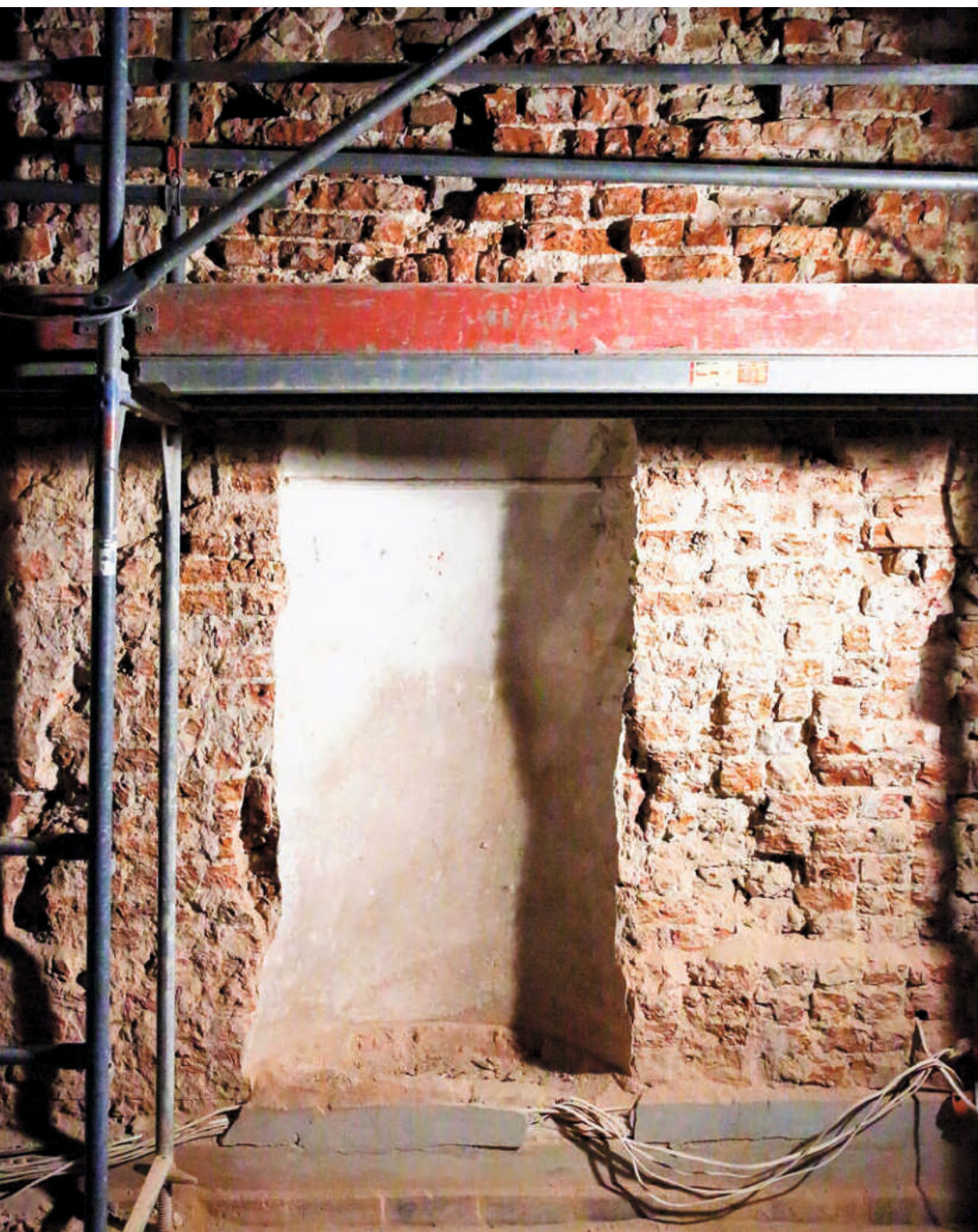
Ilustracja 55. Nawapółnocna w trakcie prac konserwatorskich. Widoczny odsłonięty ceglany wątek ściany po usunięciu cementowych tynków z odkrytą niszą ławaterza. Fot. A. Nowak, 2017
