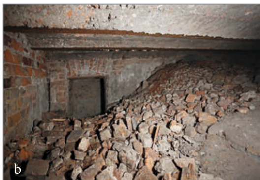
Ilustracja 22 a, b. Odkryta przestrzeń strychowa nad dużą zakrystią, ściana zachodnia: (a) zagruzowane wejście na strych; (b) przysłonięte gruzem wejście do klatki schodowej biegnącej w grubości muru między zakrystiami. Fot. A. Nowak, 2019
