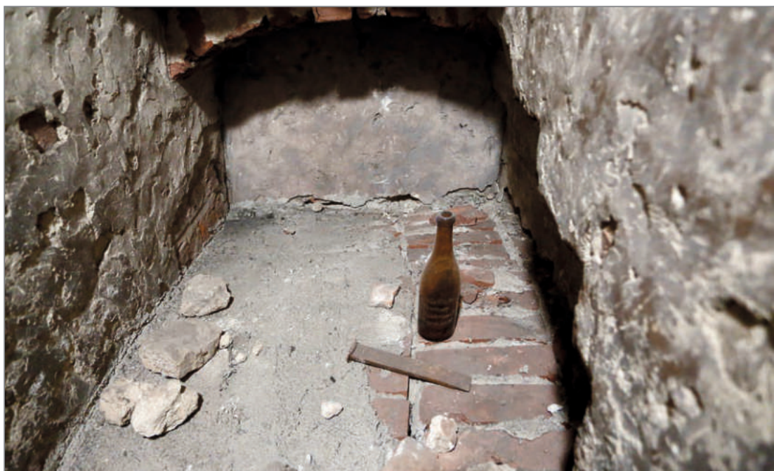
Ilustracja 30. Wnętrze klatki schodowej odkrytej w grubości muru między małą a dużą zakrystią. Na „dnie” klatki znaleziono pozostawiony stalowy przecinak i butelkę po piwie (ok. 1900r.) z browaru Neuländer Dampfbrauerei w Nysie. Fot. A. Nowak, 2019
