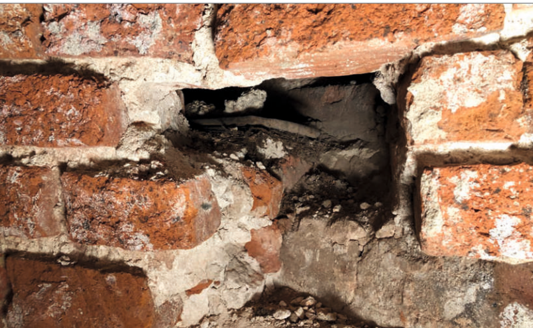
Ilustracja 27. Nawa południowa w trakcie prac konserwatorskich. Widoczny otwór odsłaniający odkryty relikwiarz wnętrza owalnej klatki schodowej. Na ceglanych schodach pozostałości ptasiego gniazda ze zwitkiem pergaminu zapisanym pismem gotyckim. Fot. M. Wawrzekiewicz. 2019
