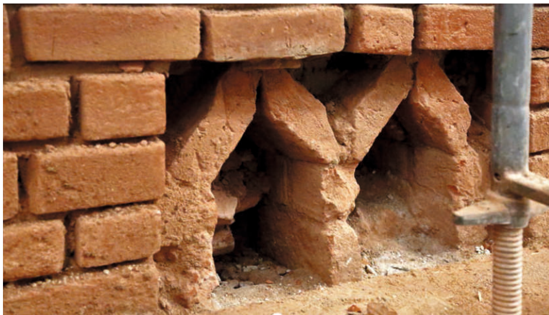
Ilustracja 54. Nawa południowa w trakcie prac konserwatorskich. Odkryte spod warstw przemurowań przypuszczalnie XIV-wieczne otwory wentylacyjne (?) znajdujące się na poziomie posadzki. Fot. A. Nowak, 2019
