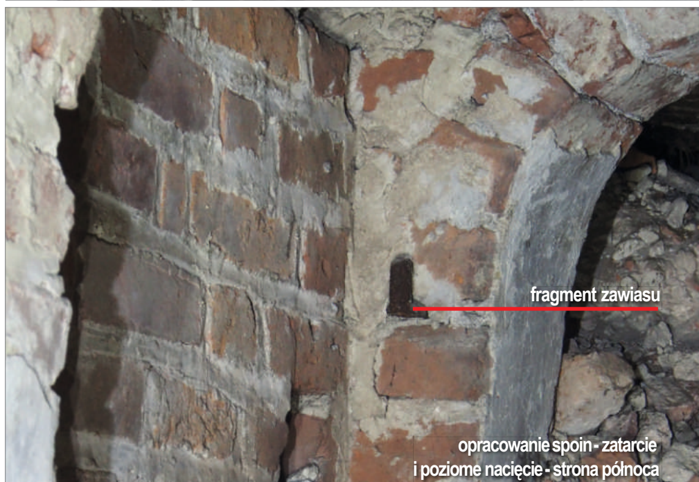
Ilustracja 49. Jedno z dwóch przejść pomiędzy pomieszczeniami nad zakrystiami południowymi. Fot. P. Filipowicz, 2019
