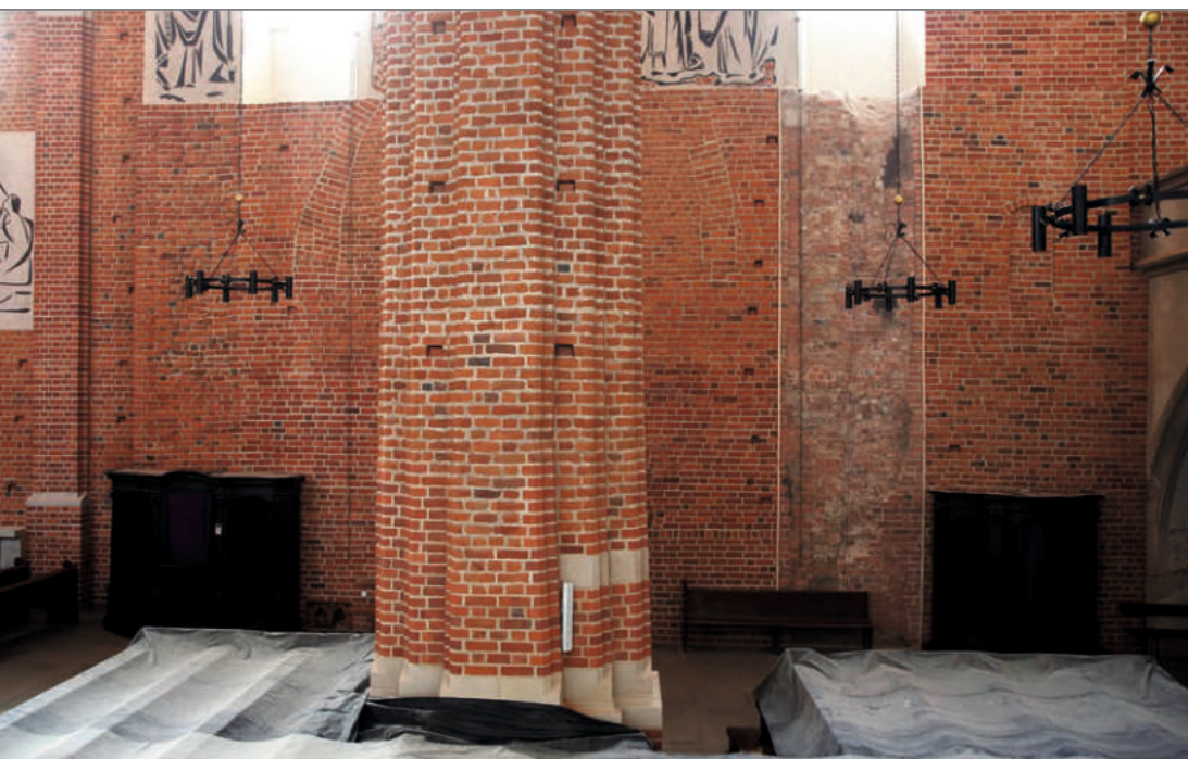
Ilustracja 36. Widok południowej ściany katedry po zakończeniu prac konserwatorskich. Fot. A. Nowak, 2019
