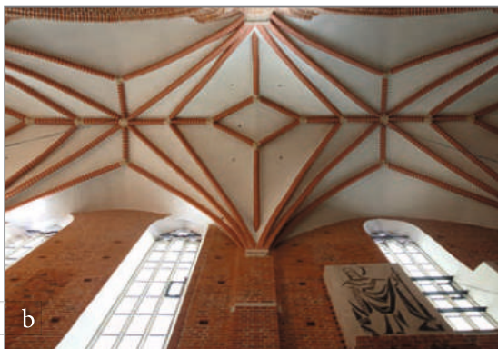
Ilustracja 17. a, b. Sklepienie nawy południowej: (a) stan przed konserwacją; (b) stan po konserwacji. Fot. A. Nowak, 2017, 2019
