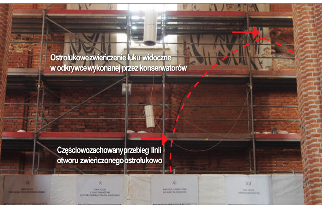
Ilustracja 50. Fragment zamurowanej arkady zwieńczonej ostrołukowo pomiędzy помещением nad główną zakrystią i nawą południową. Fot. P. Filipowicz, 2019
