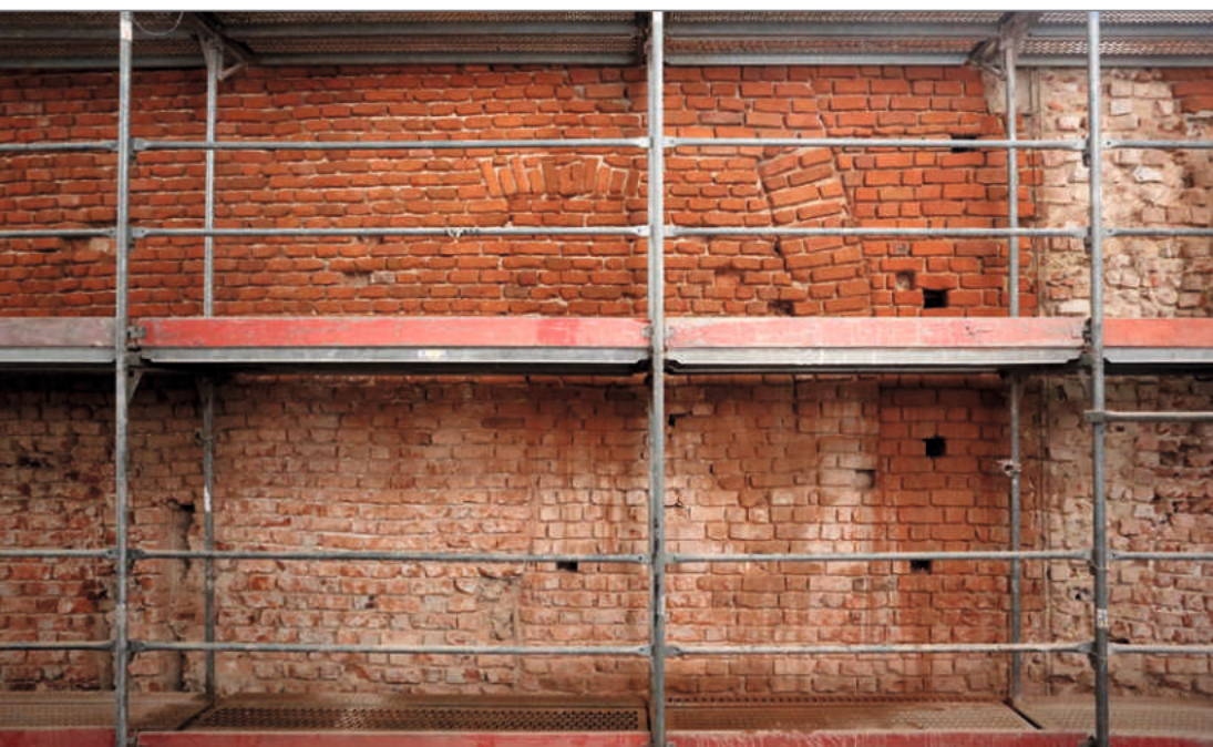
Ilustracja 25. Nawapołudniowa w trakcie prac konserwatorskich. Widoczny odsłonięty ceglany wążek ściany po usunięciu cementowych tynków w trakcie odczyszczania powierzchni cegieł. Fot. A. Nowak, 2019
