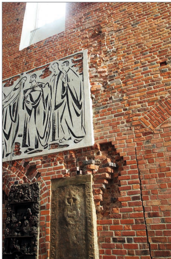
Ilustracja 39. Fragmenty murów pozbawionych wątku, interpretowane jako relikty ścian biegnących do wnętrza nawy, nawa północna. Fot. A. Nowak, 2018
