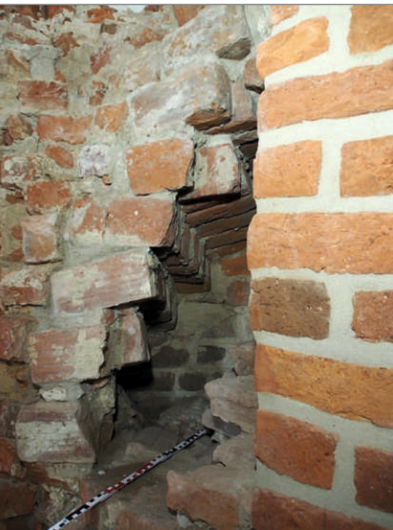
Ilustracja 44. Odkryte przesklepienie owalnej klatki schodowej. Fot. P. Filipowicz, 2019
