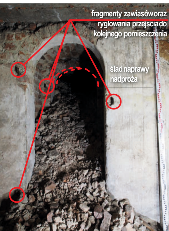
Ilustracja 48. Jedno z dwóch przejść pomiędzy pomieszczeniami nad zakrystiami południowymi. Fot. P. Filipowicz, 2019
