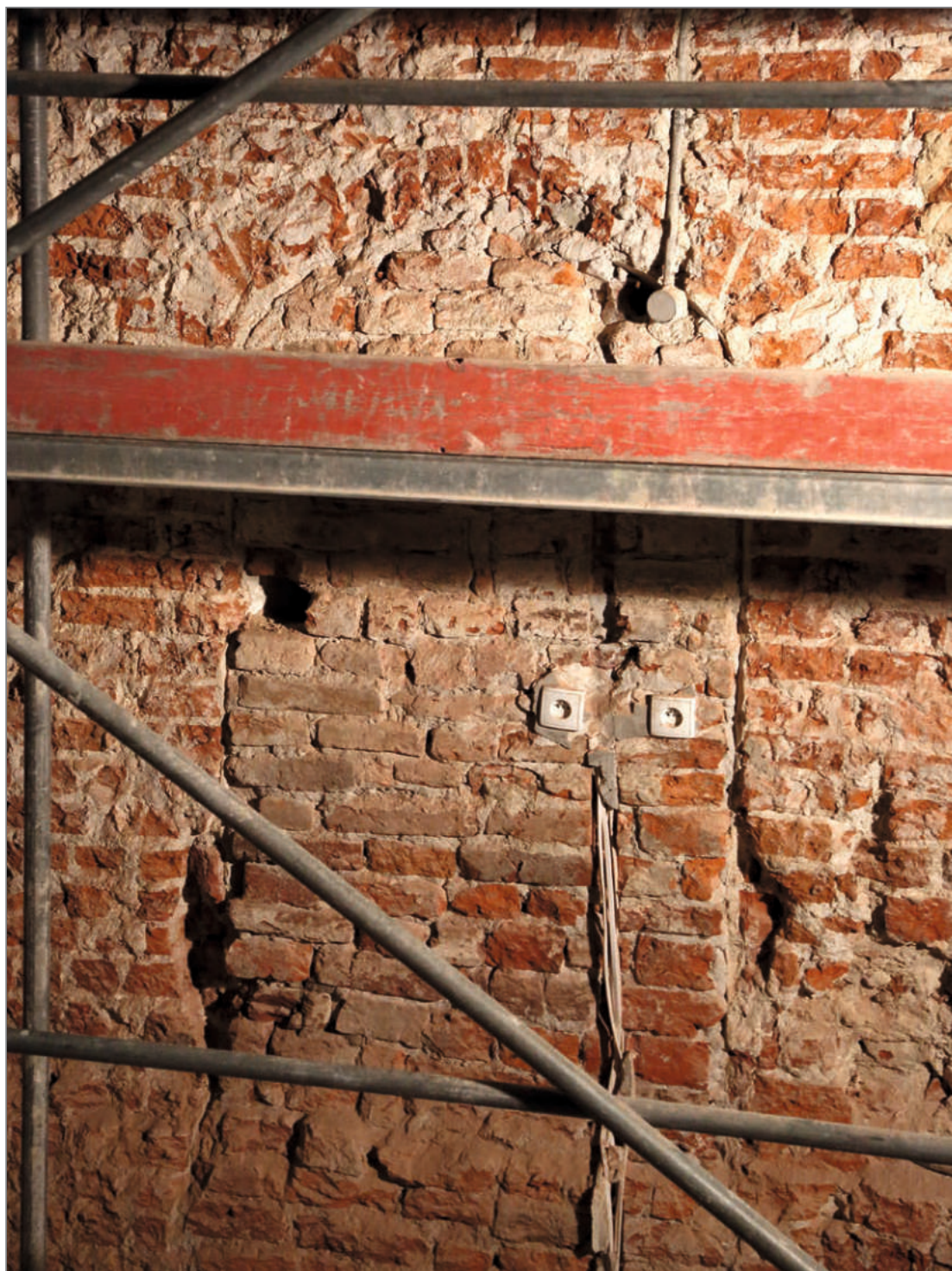
Ilustracja 26. Nawapółnocna w trakcie prac konserwatorskich. Widoczny odsłonięty ceglany wątek ściany po usunięciu cementowych tynków z odkrytym zarysem zamurowanej niszy ławeterza (?). Fot. A. Nowak, 2017
