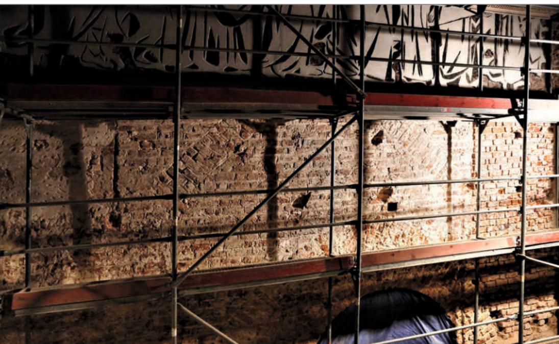
Ilustracja 24. Nawapółnocna w trakcie prac konserwatorskich. Odsłonięty ceglany wążek ściany po usunięciu cementowych tynków z wyraźnie widocznymi śladami historycznych przekształceń świątyni. Fot. A. Nowak, 2017
