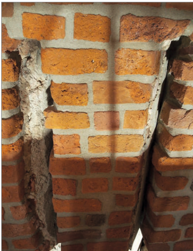
Ilustracja 51. Fragment zamurowanego, zwężanego otworu okiennego na linii podziału przęsła kościoła, glif wschodni. Fot. A. Nowak, 2019
