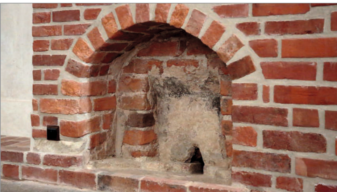
Ilustracja 38. Relikt lawaterza i odprowadzenie wody. Fot. A. Nowak, 2018
