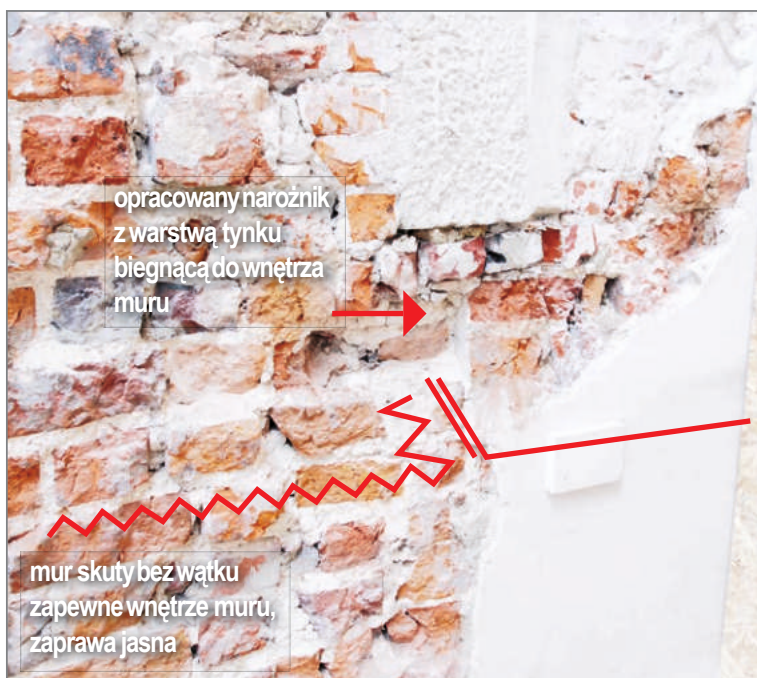
Ilustracja 44. Odkryte przesklepienie owalnej klatki schodowej. Fot. P. Filipowicz, 2019
