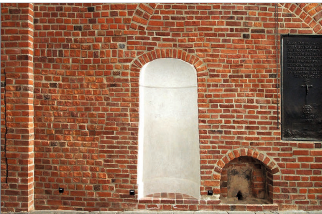
Ilustracja 37. Relikt lawaterza i odprowadzenie wody. Fot. A. Nowak, 2018
