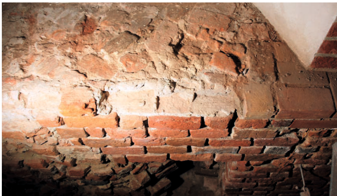
Ilustracja 53. Nawa południowa w trakcie prac konserwatorskich. Widoczna górną partia zamurowania reliktywów wnętrza odkrytej owalnej klatki schodowej, które obecnie jest parapetem wnęki okiennej. Fot. M. Wawrzekiewicz, 2019
