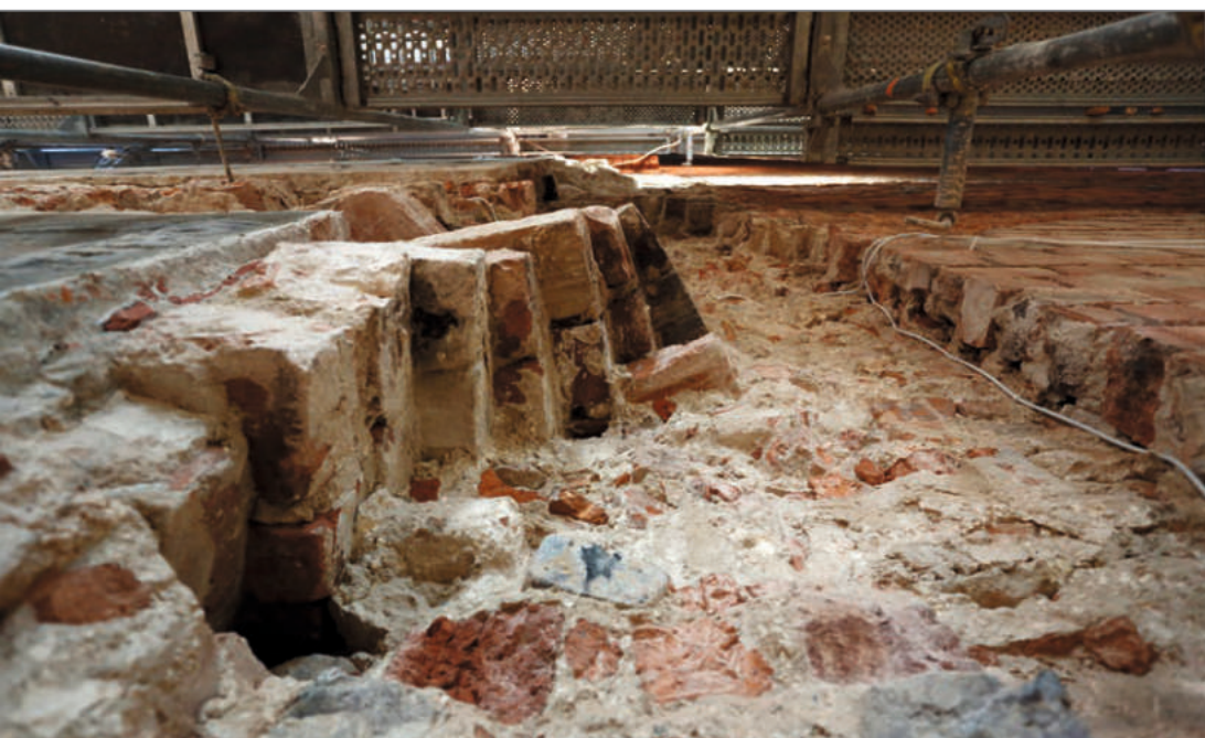
Ilustracja 28. Nawa południowa w trakcie prac konserwatorskich po usunięciu tynków. Widoczne, odkryte ceglane strzępia muru zamykające od wschodu zakrycie z okresu średniowiecza. Fot. A. Nowak, 2018
